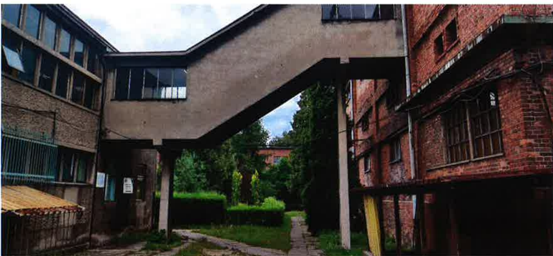
Fot. 2 Przewiązka pomiędzy starą i nową łaźnią - widok od strony zachodniej.
