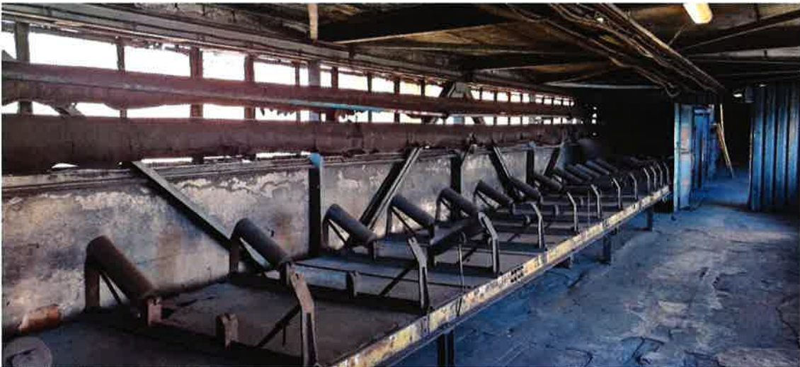
Fot. 8 Pomost „C” - wewnątrz, przenośnik.
