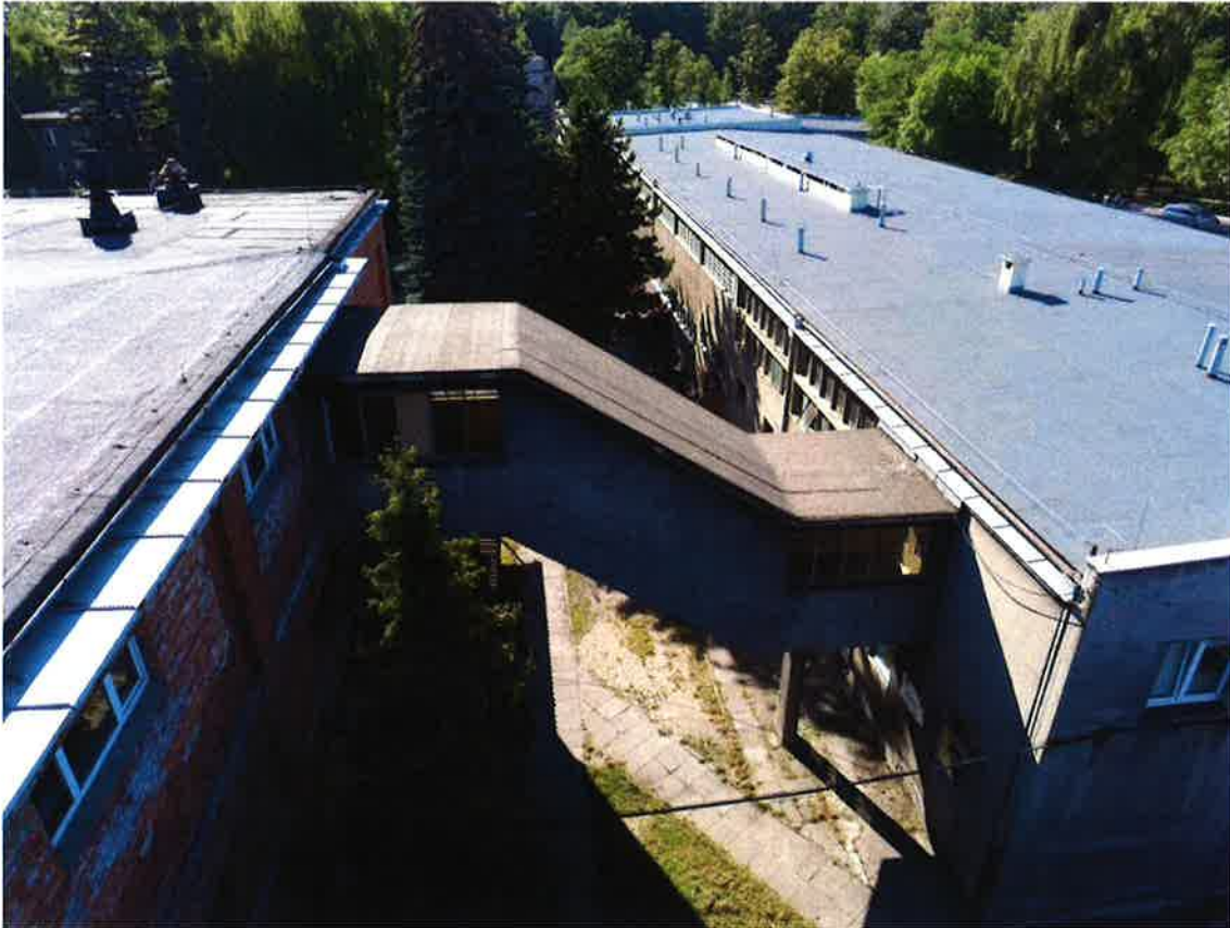
Fot. 1 Przewiązka pomiędzy starą i nową łaźnią - widok od strony wschodniej.
