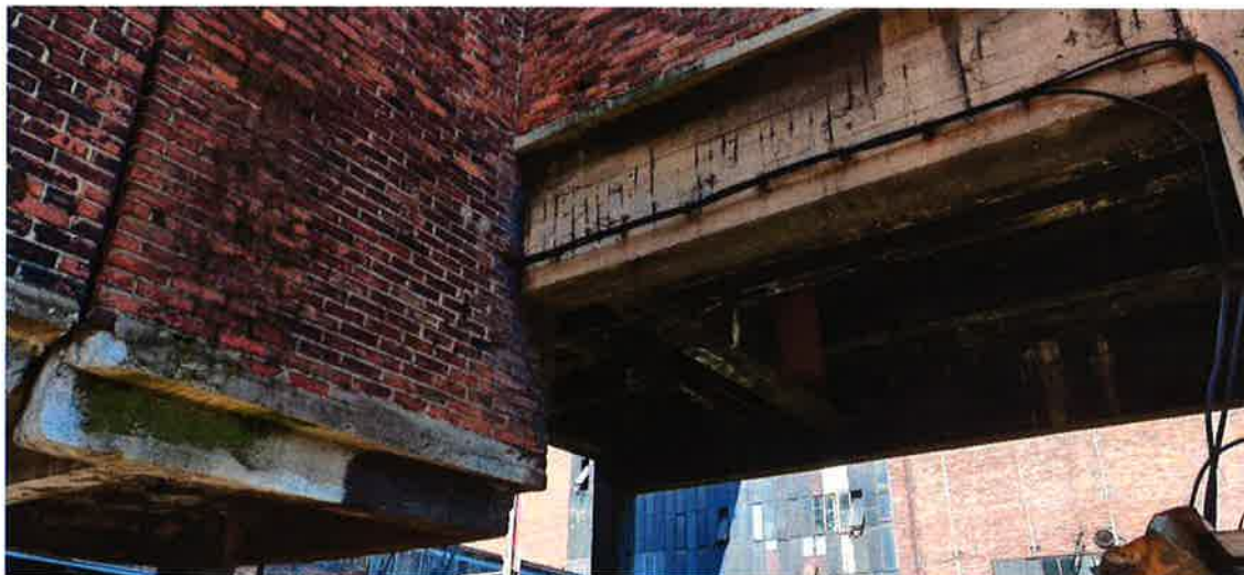
Fot. 13 Budynek wysypu niesortu nr 2 - konstrukcja stropu.
