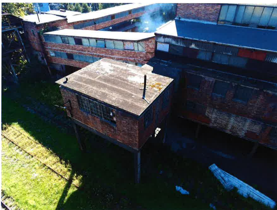
Fot. 14 Budynek wysypu niesortu nr 2 - widok od strony północno-wschodniej.
