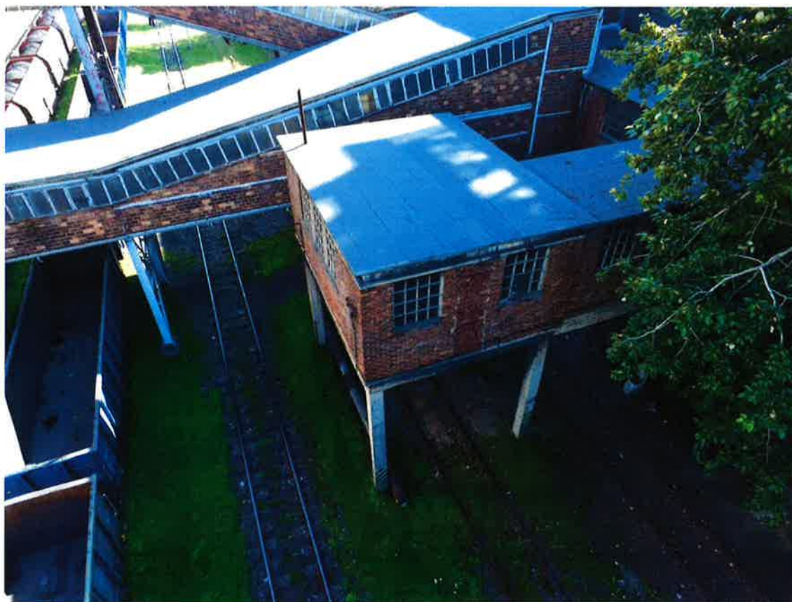
Fot. 4 Budynek wysypu niesortu nr 1 - widok od strony północno-wschodniej.
