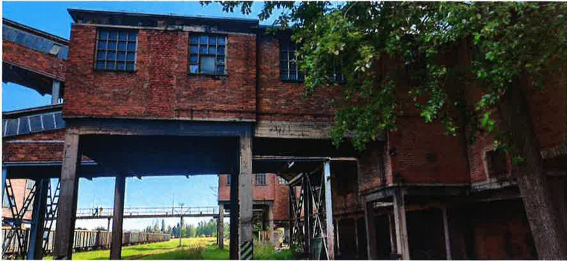
Fot. 5 Budynek wysypu niesortu nr 1 - widok od strony północnej.
