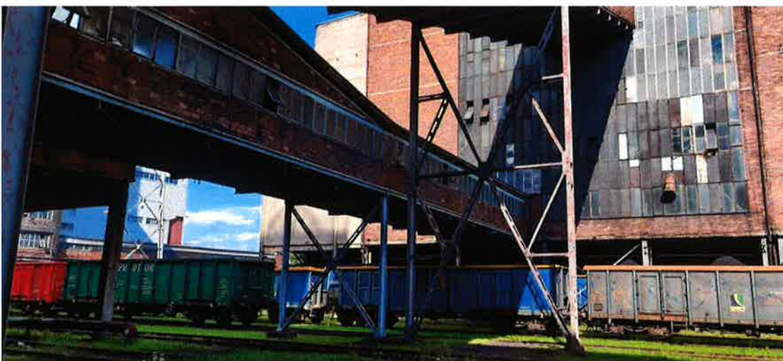
Fot. 9 Pomosty „C” i „A” - podpory pośrednie.
