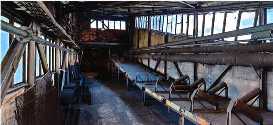
Fot. 7 Pomost „C” - wewnątrz, kratowa konstrukcja ścian, przenośnik.
