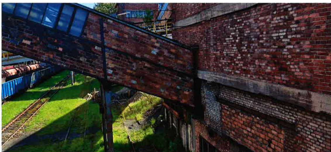
Fot. 16 Pomost „M”- widok od strony północno-zachodniej.
