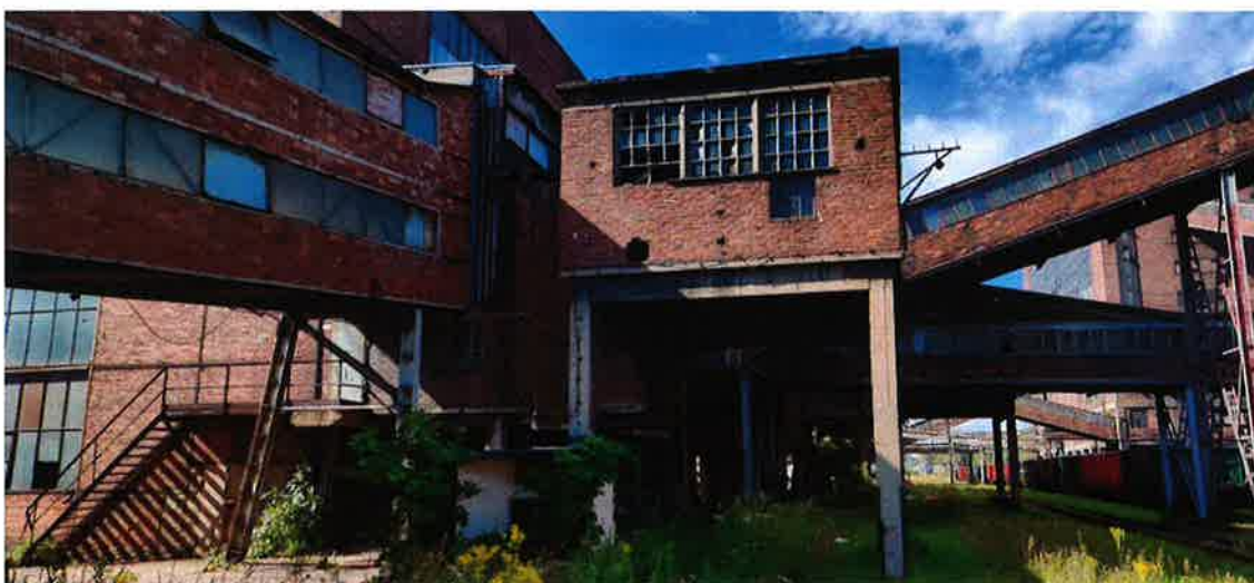
Fot. 12 Budynek wyspu niesortu nr 2 - widok od strony południowej.
