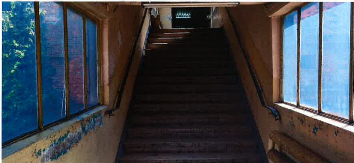
Fot. 3 Przewiązka pomiędzy starą i nową łazienką - wewnątrz.
