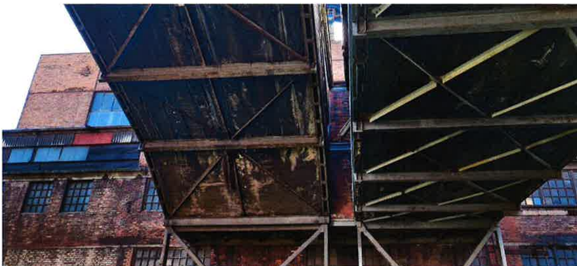
Fot. 10 Pomosty „C” i „A” - konstrukcje podestu.
