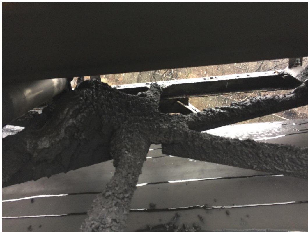
Foto 5 Osad węglowy na elementach stężenia poziomego w poziomie górnych pasów
