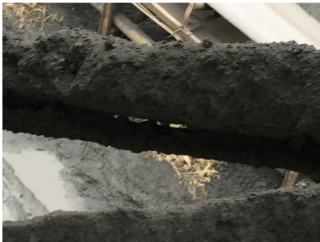
Foto 4 Uszkodzenia korozyjne pasa dolnego kraty
