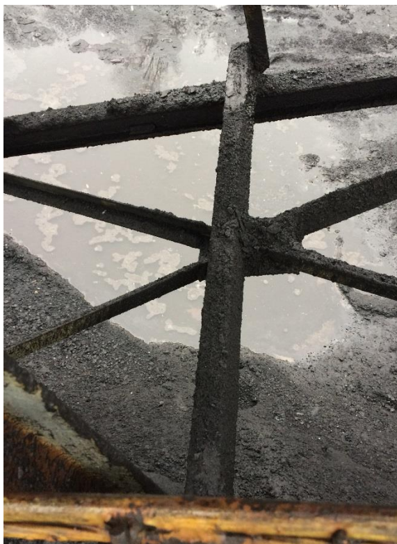
Foto 6 Osad węglowy na stężeniu poziomym w poziomie dolnych pasów
