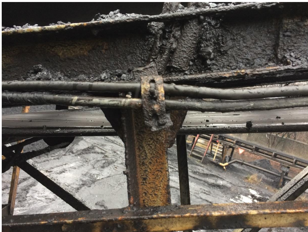
Foto 3 Uszkodzenia mechaniczne pasa górnego kraty
