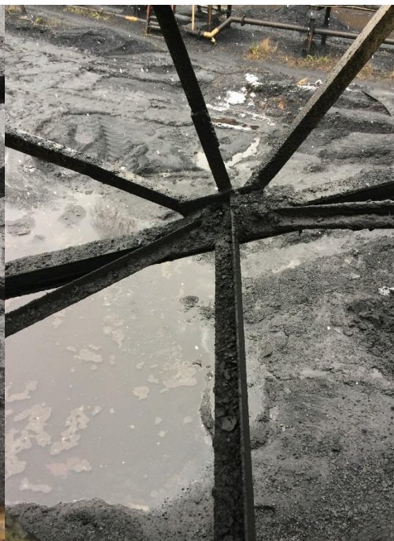
Foto 7 Osad węglowy na stężeniu poziomym w poziomie dolnych pasów Widoczna poprzednia naprawa słupka
