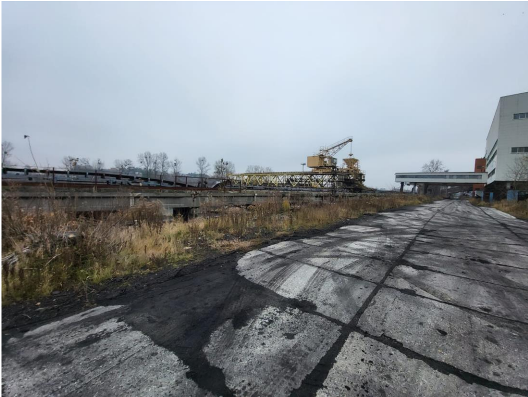
3. Pomost nr 13(O) łączący budynek stacji przesypowej nr 4 z pomostem nr 18(L) 2b/3-3
