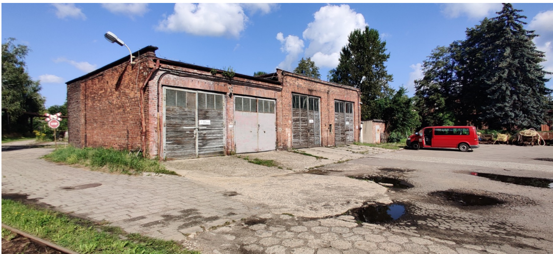
Fot. 5 Od lewej - budynek garaży samochodowych i garaże samochodowe - widok od strony południowo-wschodniej.
