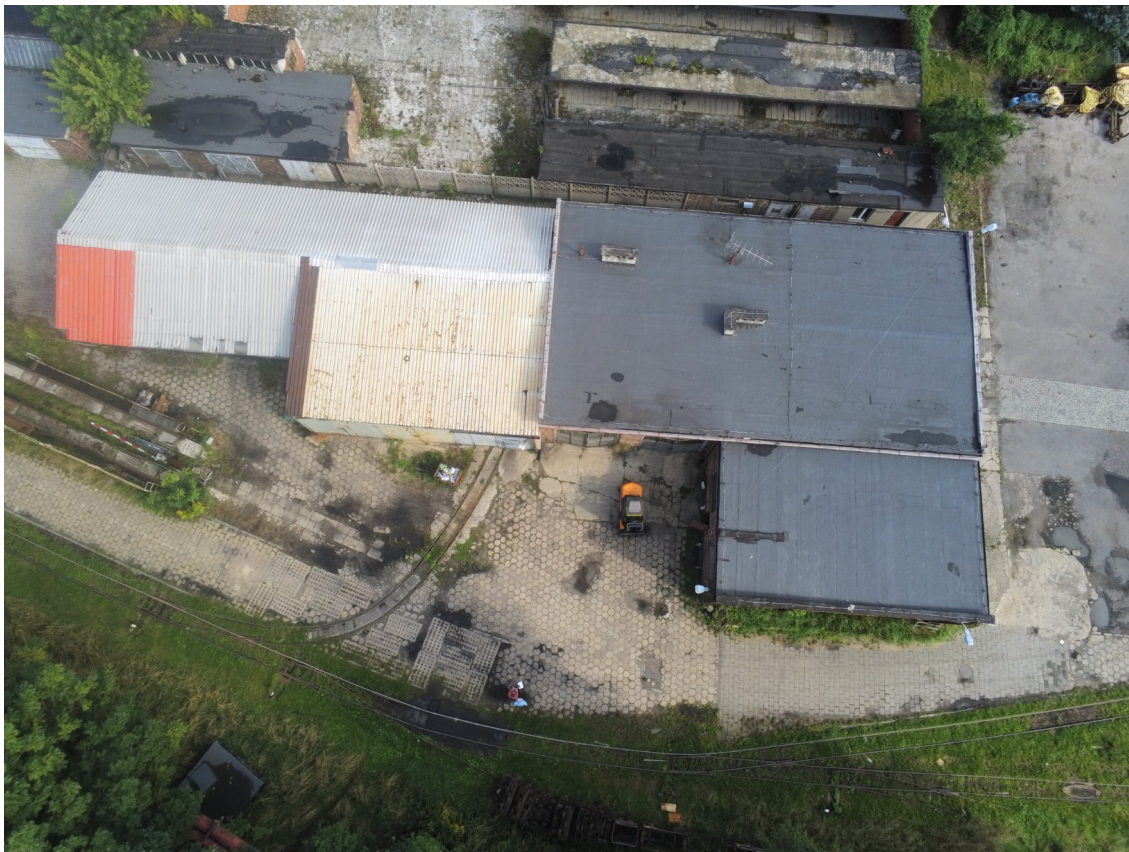
Fot. 1 Magazyn prowizoryczny na oleje i smary, garaże samochodowe, Budynek garaży samochodowych, Budynek zajezdni lokomotyw - widok z lotu ptaka od strony południowej.
