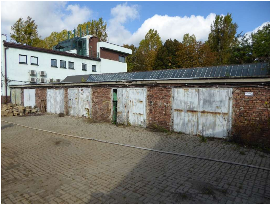
1. Budynek stacji diagnostyki samochodowej wraz z budynkiem gospodarczym
