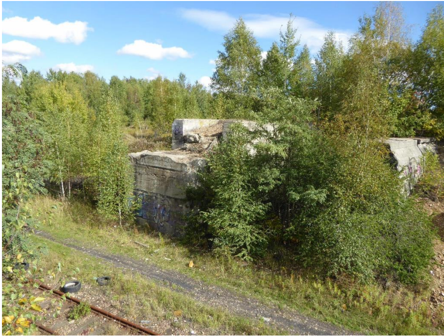
1. Wiadukt kolejowy na bocznicy
