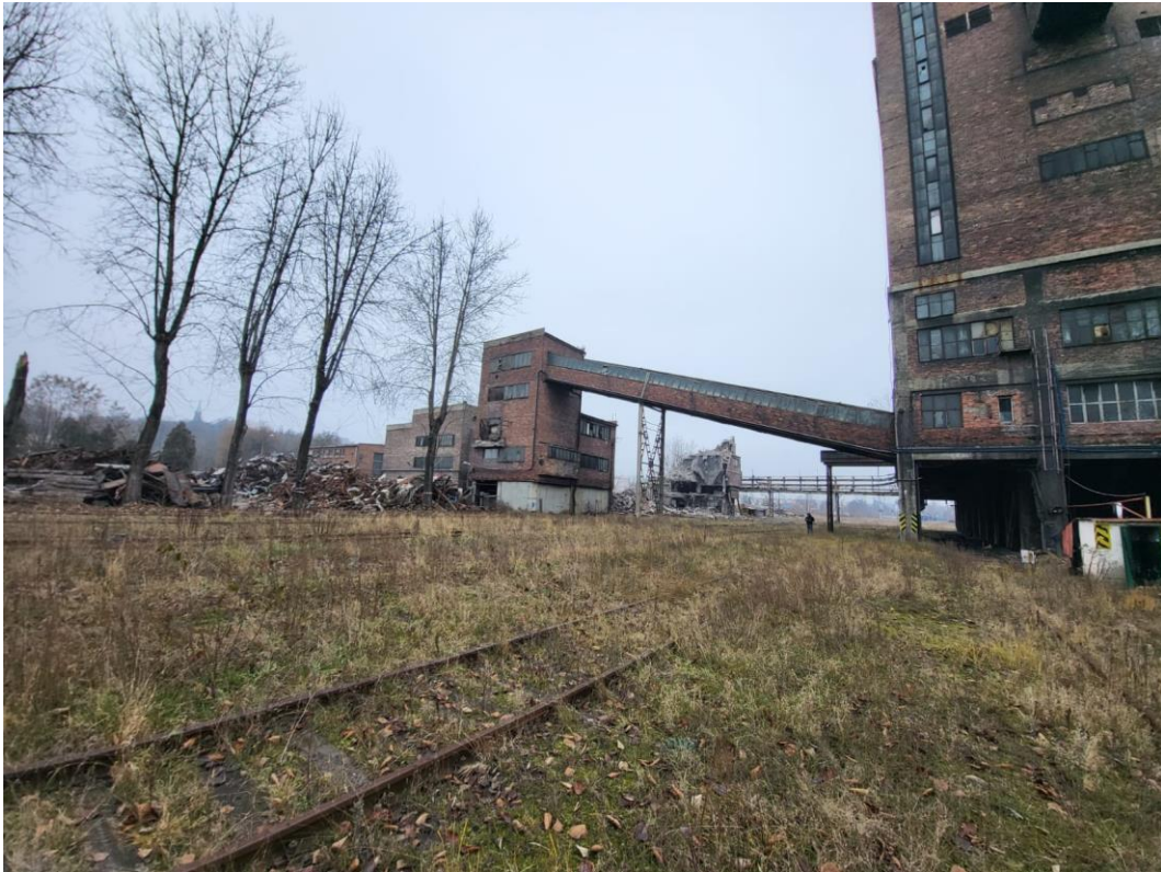
9. Pomost nr 24(E) między budynkiem płuczki i stacji przesypowej nr 5 2b/3-8; Stacja przesypowa nr 5 2b/5-2; Budynek kruszarni kamienia 2b/7
