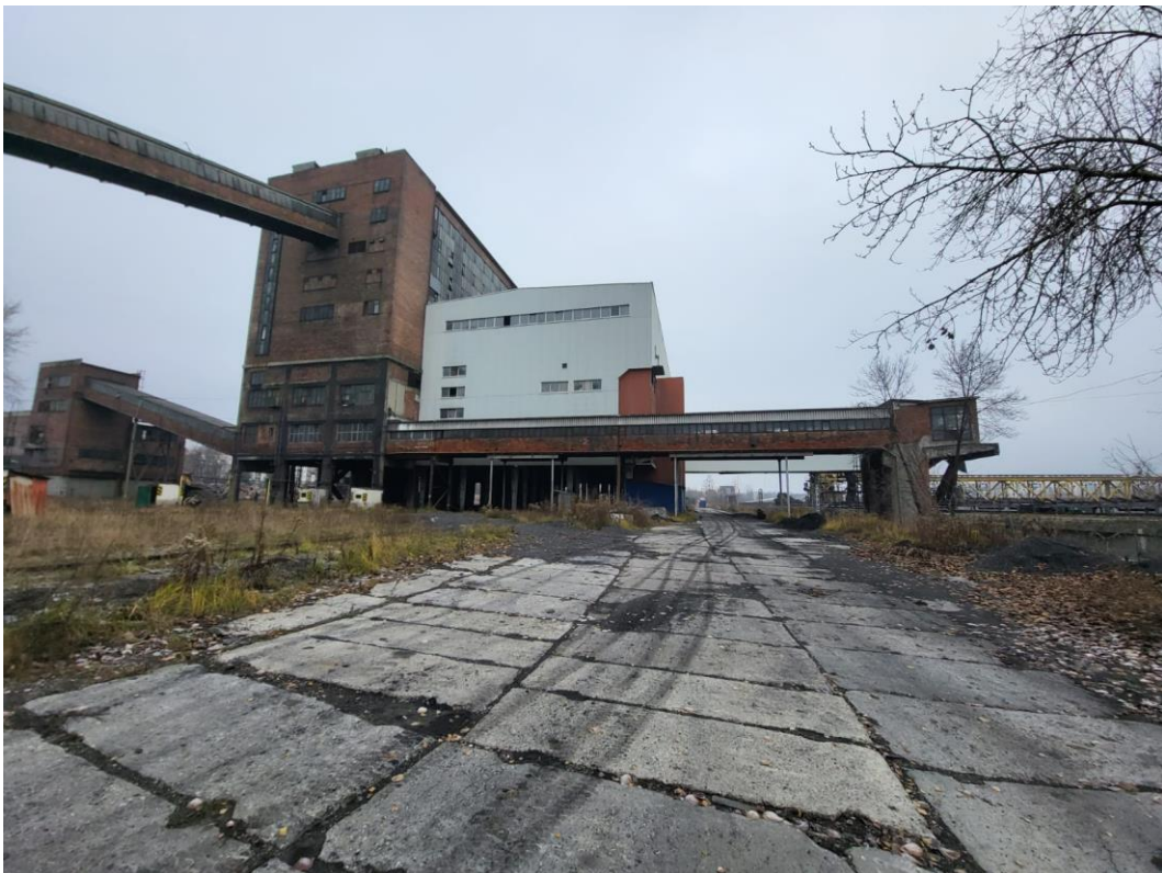
6. Pomost nr 16 (K) pomost łączący budynek płuczki z pomostem nr 13(O) 2b/3-5; Płuczka miałowa 2b/2-1; Płuczka (z wyjątkiem torów pod budynkiem płuczki) 2b/2
