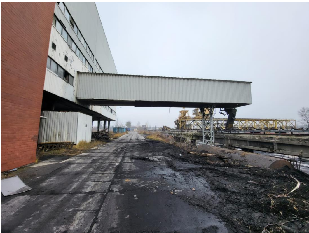
12. Pomost łączący budynek płuczki miałowej z pomostem nr 13(O) 2b/3-12
