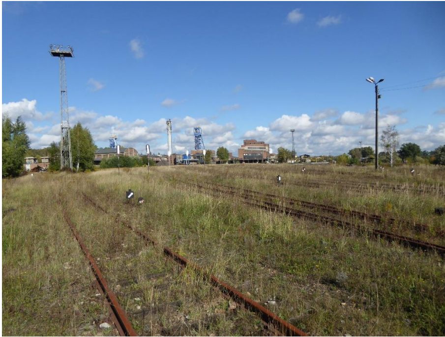
1. Bocznicą kolejową wraz z infrastrukturą kolejową
