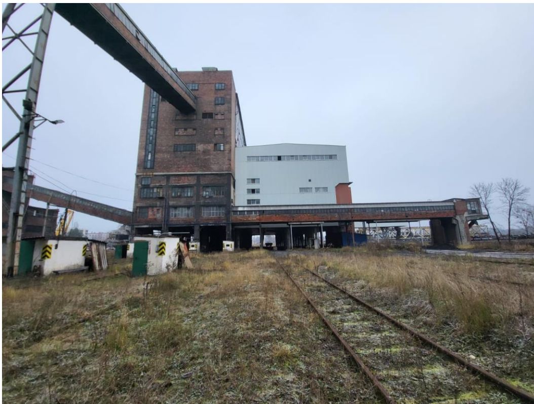
19. Pomost nr 16 (K) pomost łączący budynek płuczki z pomostem nr 13(O) 2b/3-5; Płuczka miałowa 2b/2-1; Płuczka (z wyjątkiem torów pod budynkiem płuczki) 2b/2
