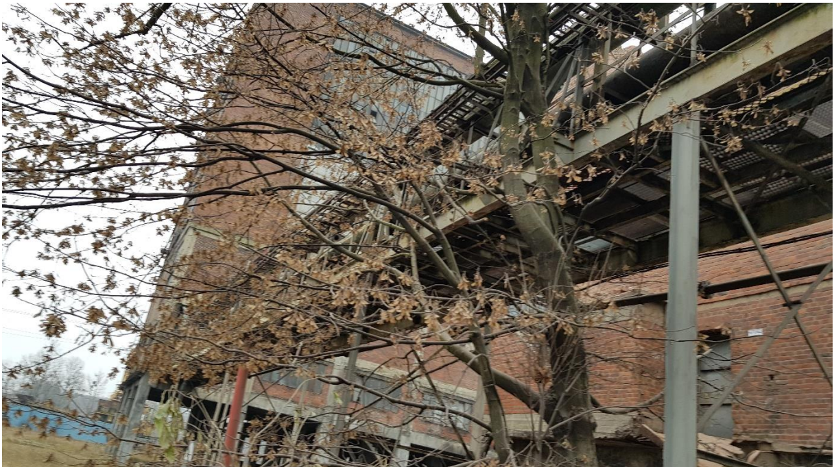
16. Pomost 17 (N) łączący budynek płuczki z odmulnikiem DORR'A 8/1
