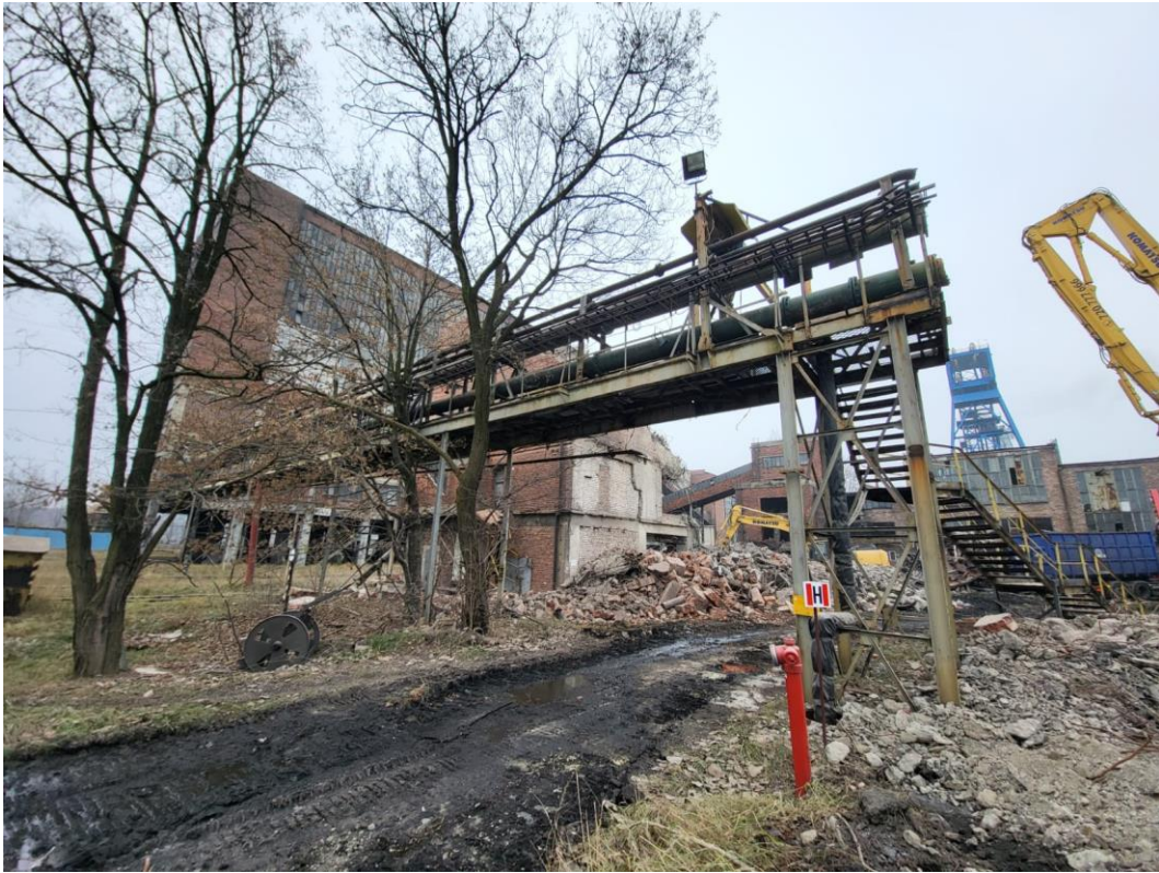
15. Pomost 17 (N) łączący budynek płuczki z odmulnikiem DORR'A 8/1
