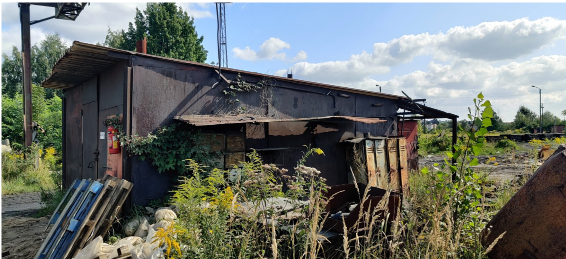
Fot. 15 Wiata przy suwnicy - widok od strony południowo-zachodniej.
