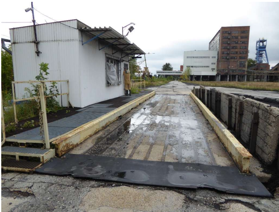
4. Budynek wagi samochodowej
