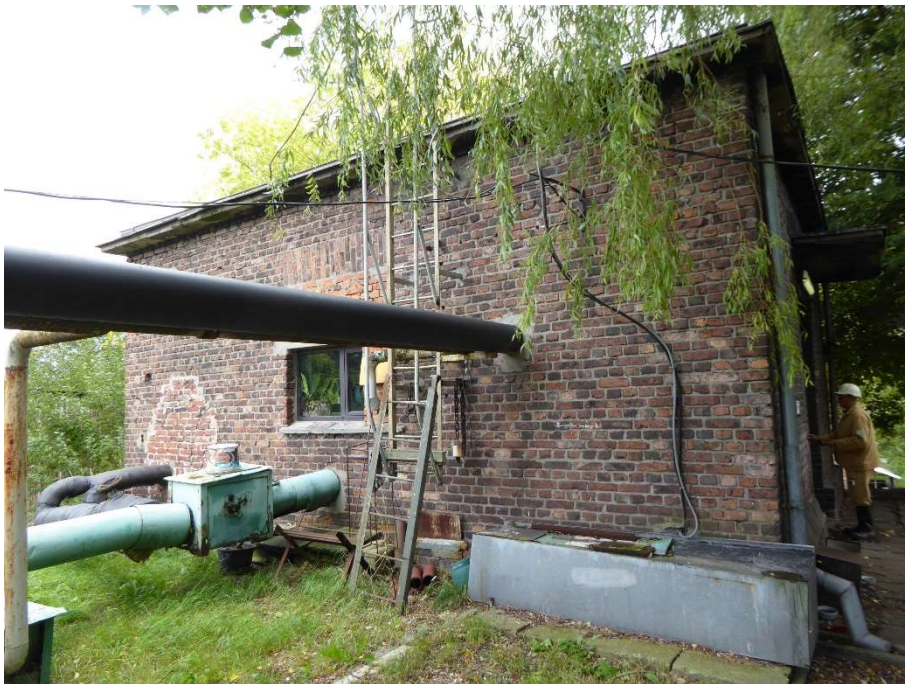
2. Budynek hydroforni II
