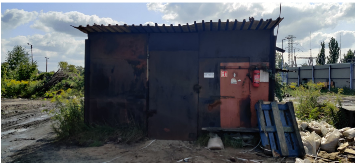
Fot. 16 Wiata przy suwnicy - widok od strony zachodniej.
