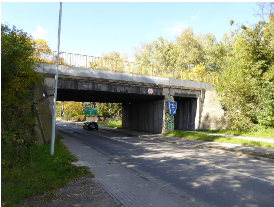
2. Wiadukt kolejowy - przejazd
