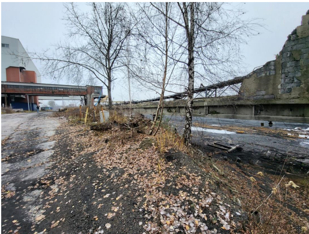
2. Pomost nr 13(O) łączący budynek stacji przesypowej nr 4 z pomostem nr 18(L) 2b/3-3
