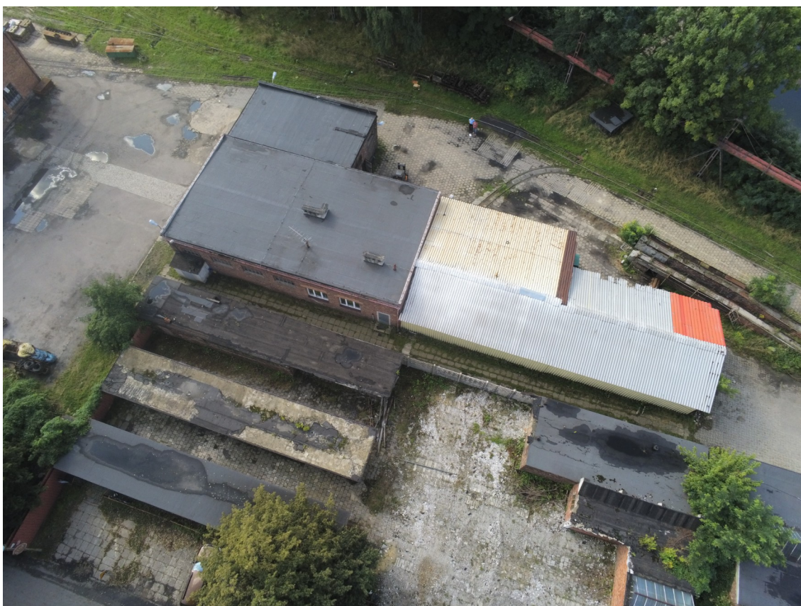
Fot. 2 Magazyn prowizoryczny na oleje i smary, garaże samochodowe, Budynek garaży samochodowych, Budynek zajezdni lokomotyw - widok z lotu ptaka od strony północnej.
