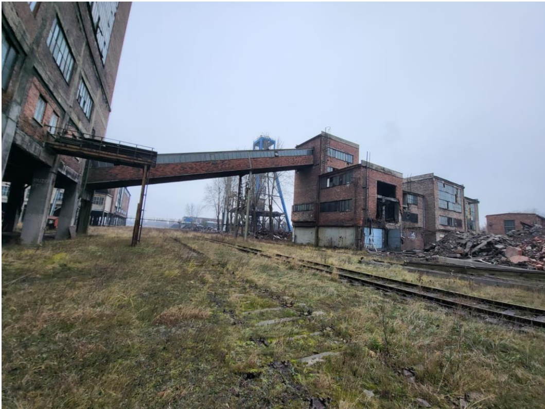
8. Pomost nr 24(E) między budynkiem płuczki i stacji przesypowej nr 5 2b/3-8; Stacja przesypowa nr 5 2b/5-2; Budynek kruszarni kamienia 2b/7
