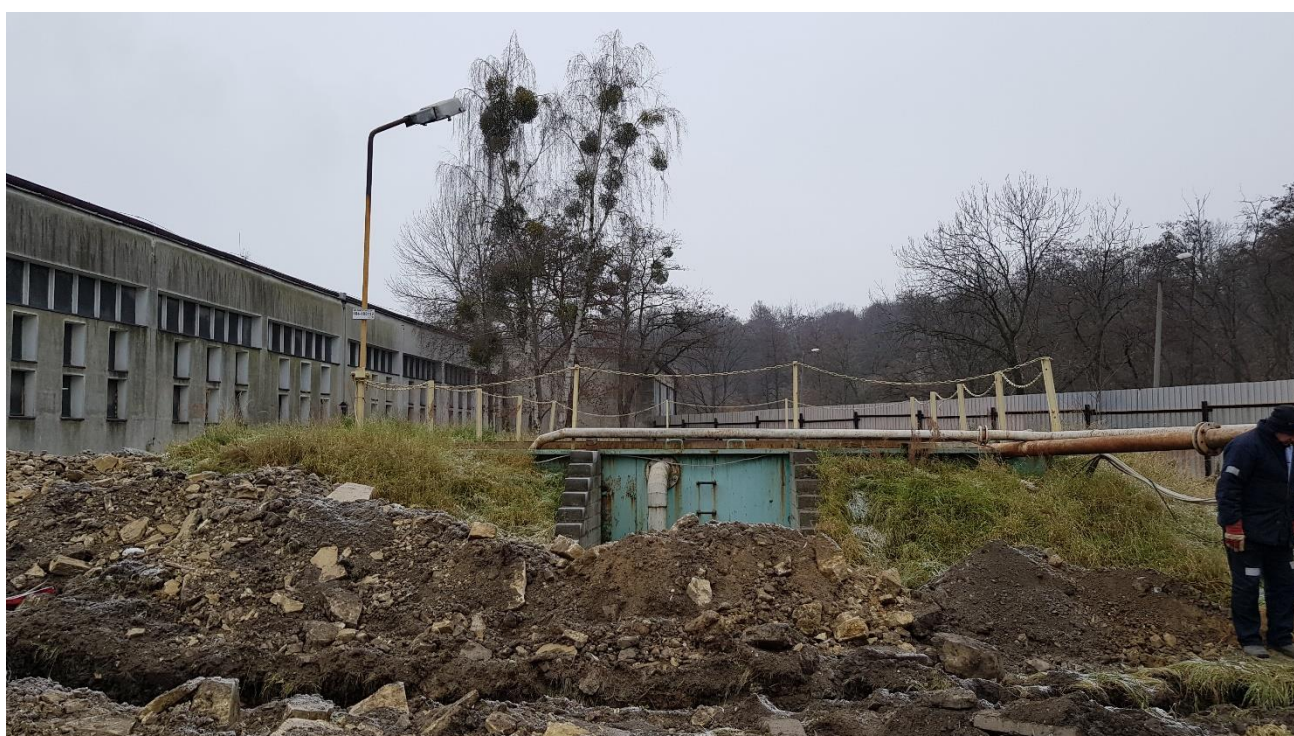
8. Zbiornik p.poż. przy budynku hydroforni 7
