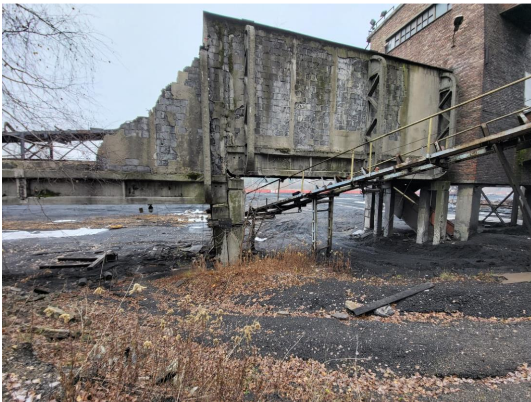
1. Pomost nr 13(O) łączący budynek stacji przesypowej nr 4 z pomostem nr 18(L) 2b/3-3
