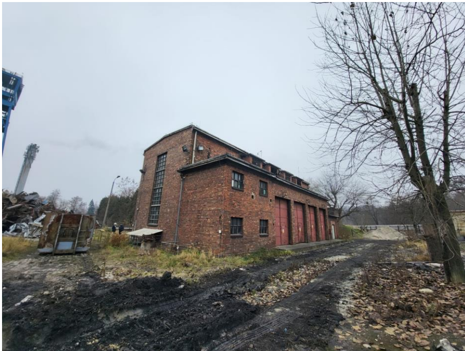
2. Budynek rozdzielni – elewacja północna i wschodnia
