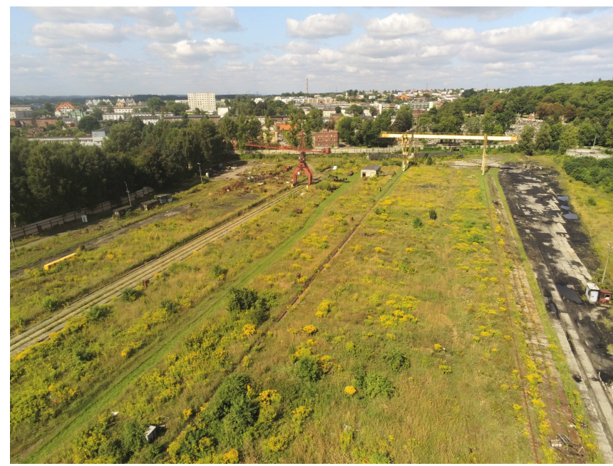
Widok ogólny placu drzewnego
