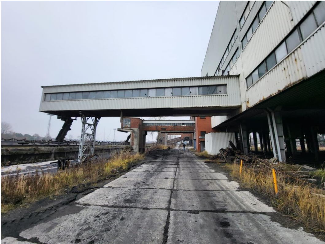
13. Pomost łączący budynek płuczki miałowej z pomostem nr 13(O) 2b/3-12
