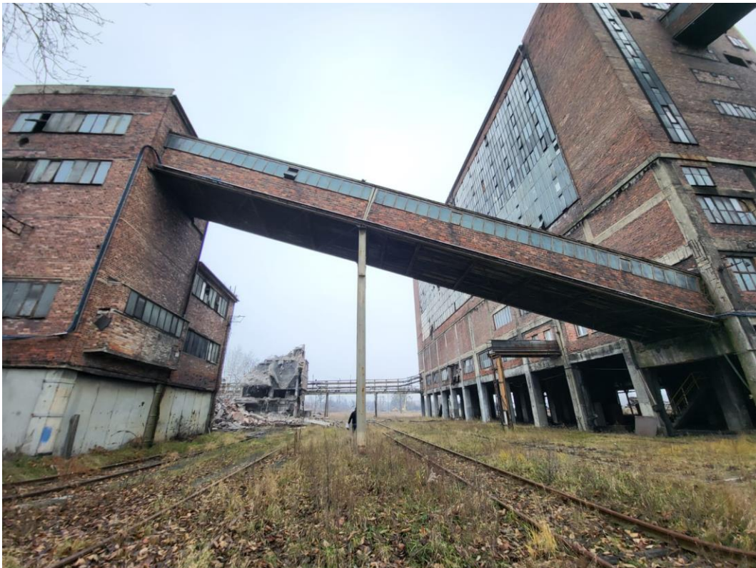
18. Pomost nr 24(E) między budynkiem płuczki i stacji przesypowej nr 5 2b/3-8
