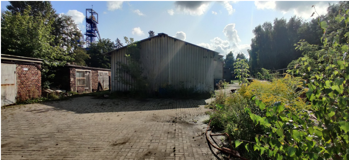
Fot. 7 Budynek zajezdni lokomotyw - widok od strony zachodniej.
