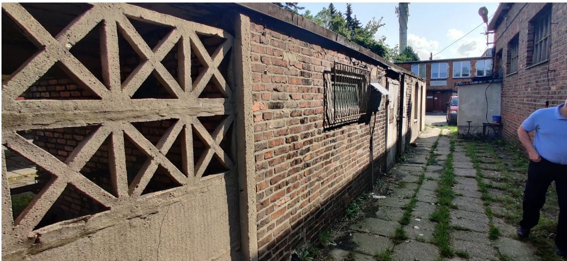
Fot. 4 Magazyn prowizoryczny na oleje i smary - widok od strony południowo-zachodniej.
