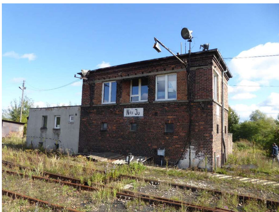
6. Budynek nastawni „JU1” (z prawej), budynek nastawni przekaźnikowej (z lewej)
