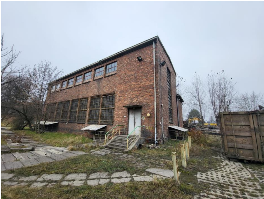
1. Budynek rozdzielni – elewacja południowa i wschodnia
