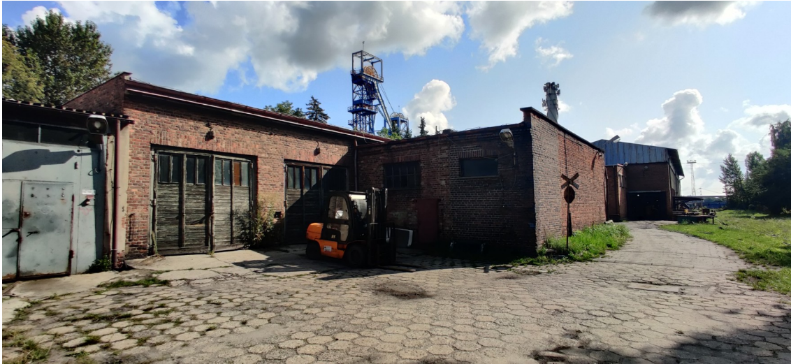
Fot. 6 Od lewej - garaże samochodowe i budynek garaży samochodowych - widok od strony południowo-zachodniej.
