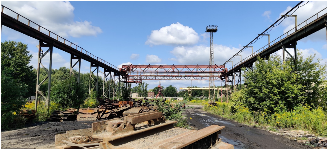
Fot. 9 Sawnica pomostowa - widok od strony wschodniej.
