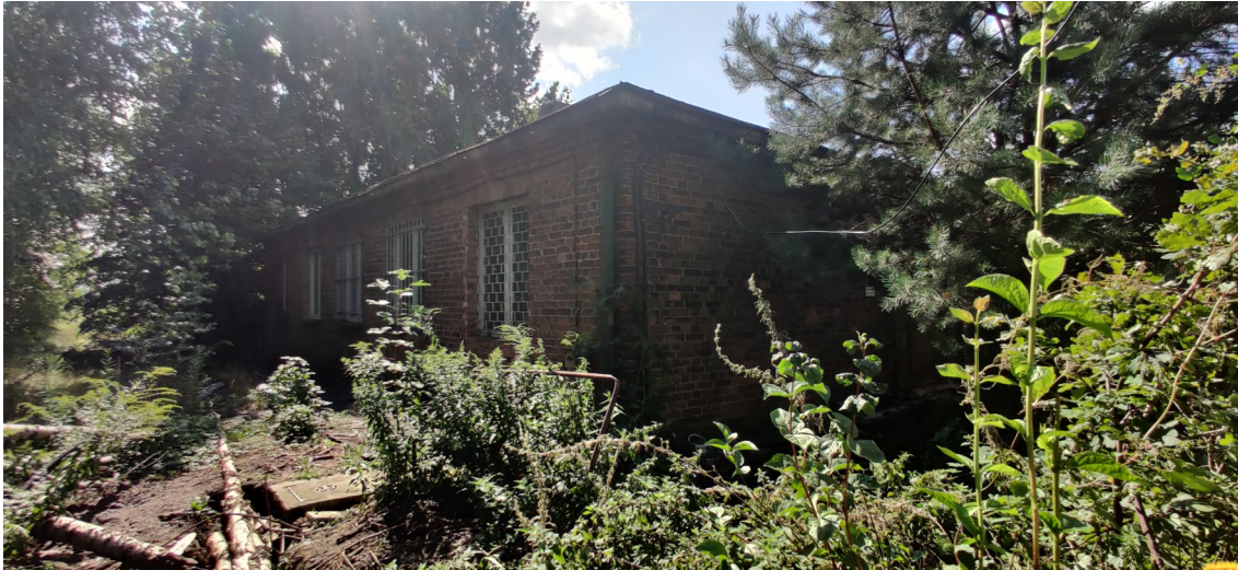
Fot. 8 Budynek ekspedycji kolejowej - widok od strony północno-zachodniej.
