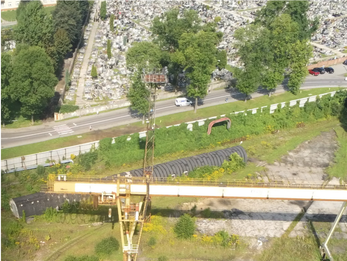
Fot. 1 Wieża reflektorowa nr 1 - widok z lotu ptaka od strony południowo-wschodniej.
