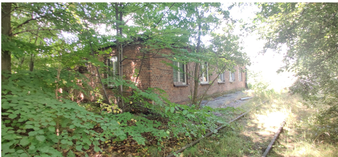
Fot. 7 Budynek ekspedycji kolejowej - widok od strony wschodniej.
