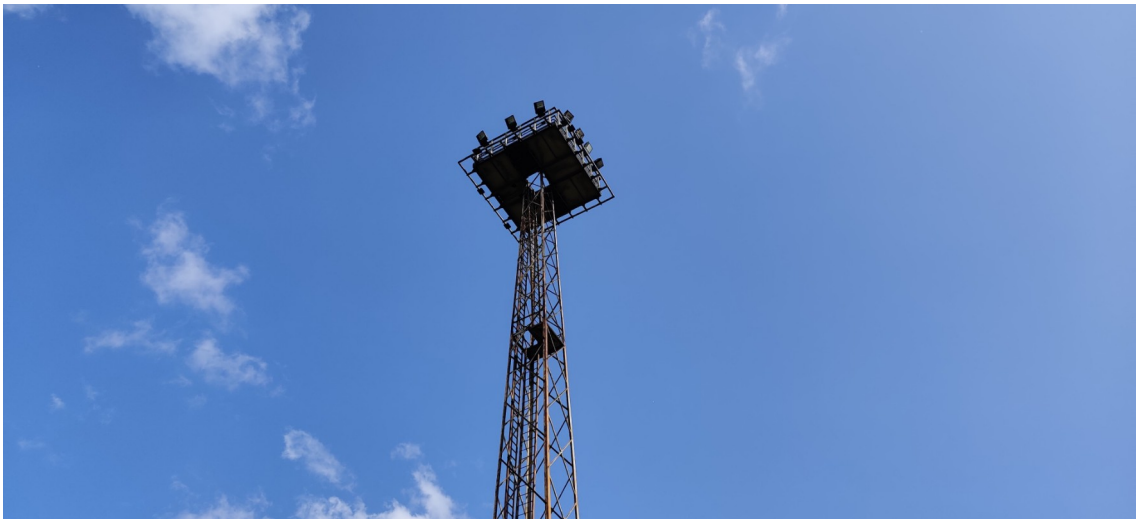
Fot. 4 Wieża reflektorowa - widok ogólny konstrukcji słupa.
