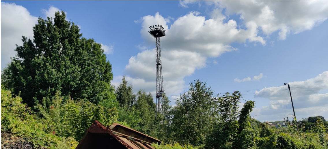
Fot. 3 Wieża reflektorowa nr 3 - widok od strony zachodniej.
