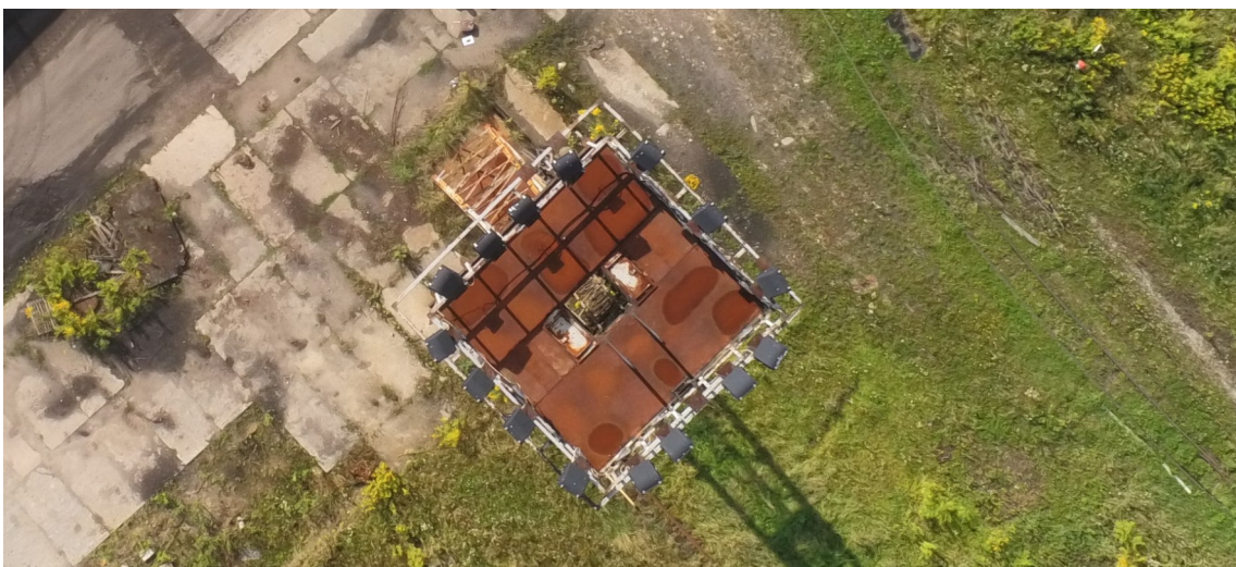
Fot. 5 Wieża reflektorowa - konstrukcja podestu.
