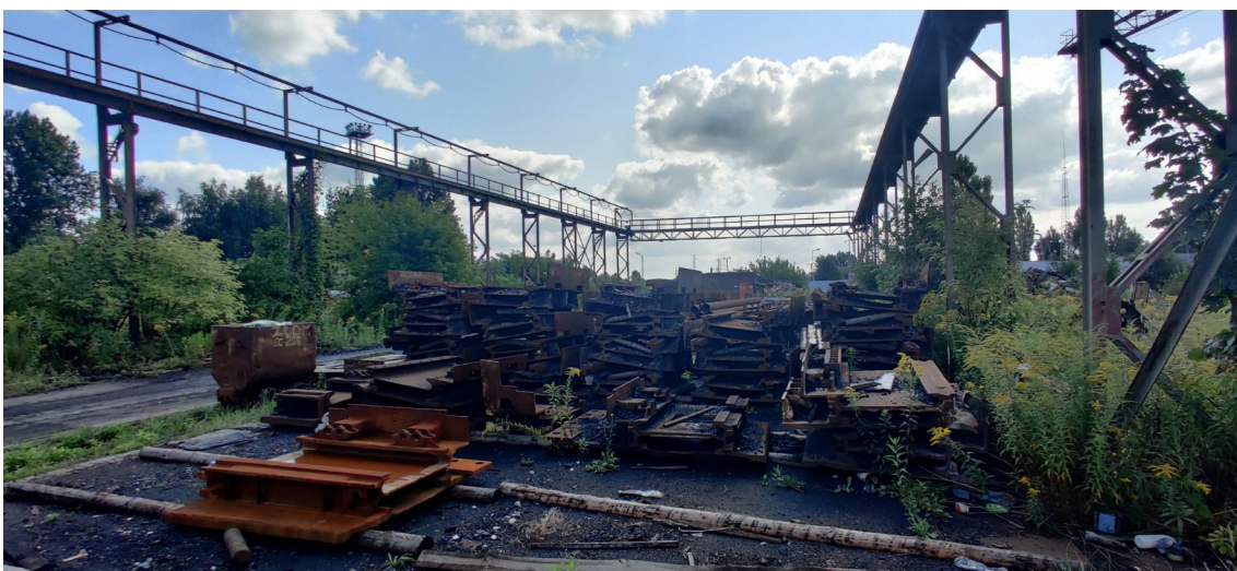
Fot. 10 Sawnica pomostowa - widok od strony zachodniej.
