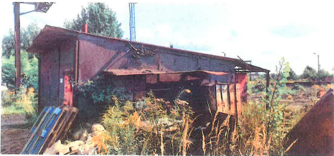
Fot. 15 Wiata przy suwnicy - widok od strony południowo-zachodniej.
