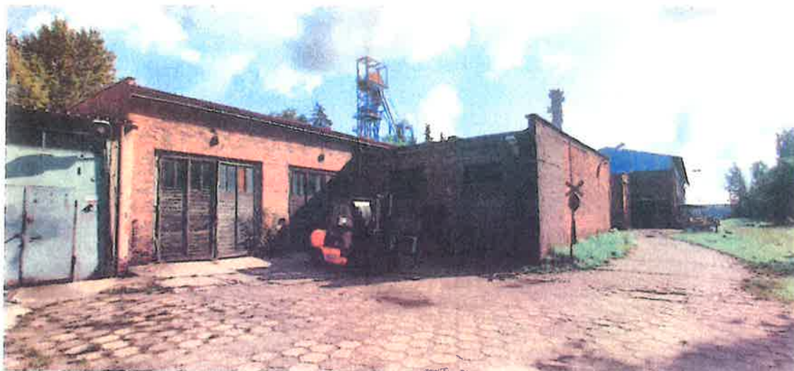
Fot. 6 Od lewej - garaże samochodowe i budynek garaży samochodowych - widok od strony południowo-zachodniej.
