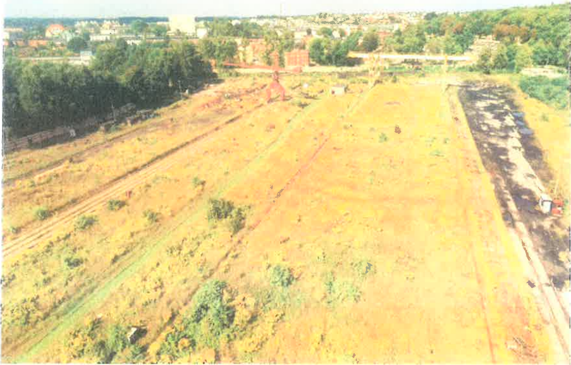
Fot. 17 Torowiska na placu drzewnym.
