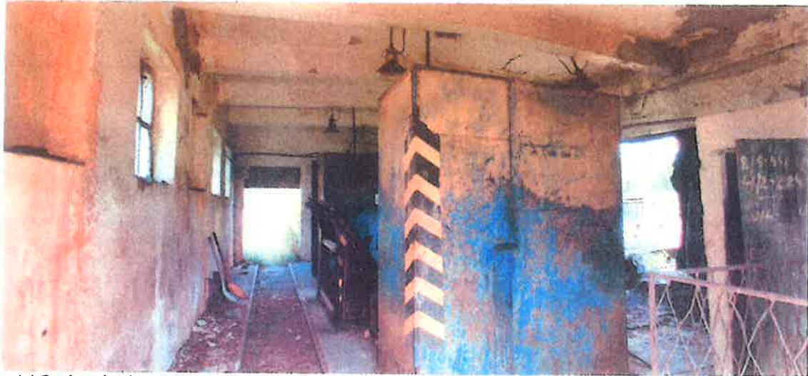
Fot. 14 Budynek olowni drewna - widok wnętrza.
