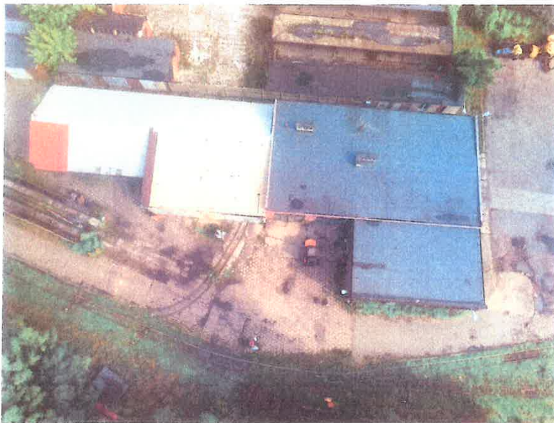
Fot. 1 Magazyn prowizoryczny na oleje i smary, garaże samochodowe, Budynek garaży samochodowych, Budynek zajezdni lokomotyw - widok z lotu ptaka od strony południowej.
