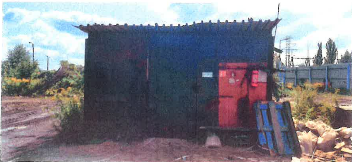
Fot. 16 Wiata przy suwnicy - widok od strony zachodniej.
