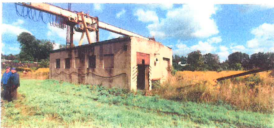
Fot. 13 Budynek ołowni drewna - widok od strony południowo-wschodniej.
