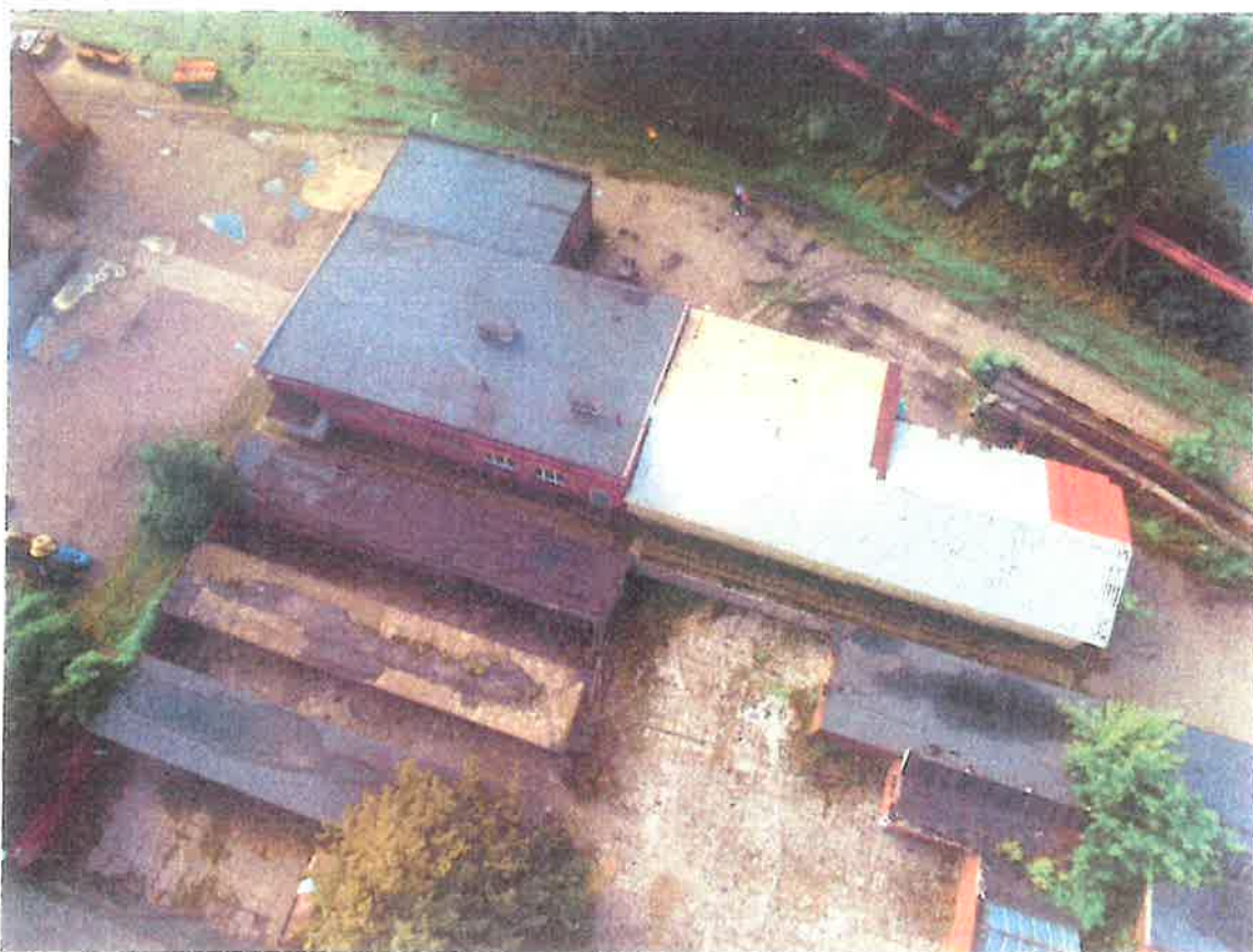
Fot. 2 Magazyn prowizoryczny na oleje i smary, garaże samochodowe, Budynek garaży samochodowych, Budynek zajezdni lokomotyw - widok z lotu ptaka od strony północnej.
