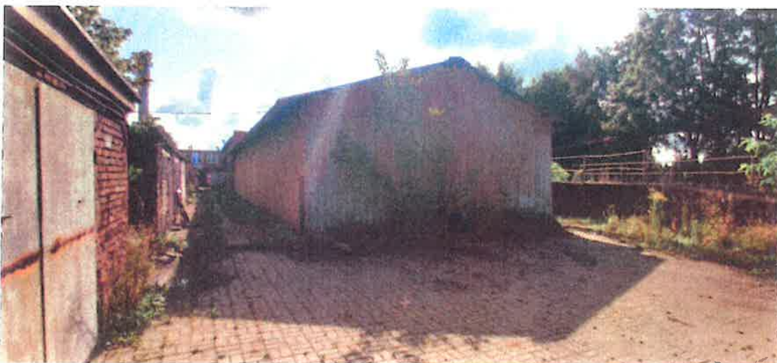
Fot. 8 Budynek zajezdni lokomotyw - widok od strony północno-zachodniej.
