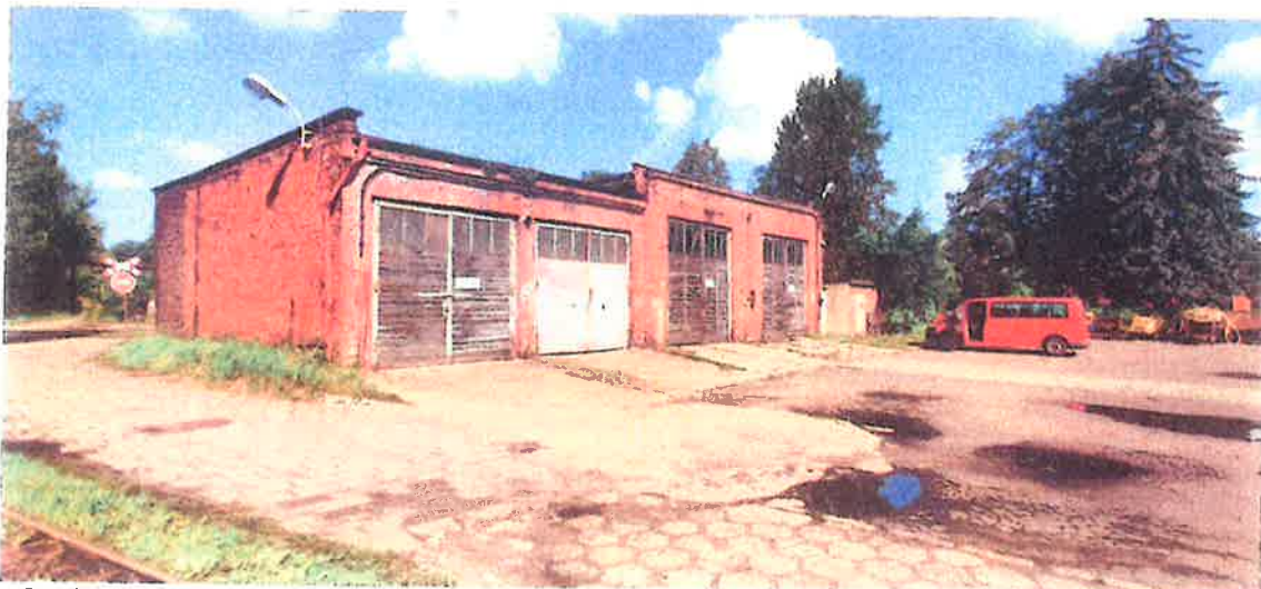
Fot. 5 Od lewej - budynek garaży samochodowych i garaże samochodowe - widok od strony południowo-wschodniej.
