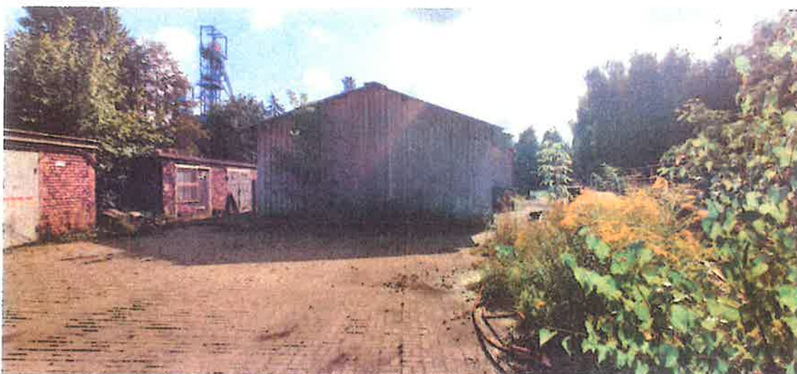
Fot. 7 Budynek zajezdni lokomotyw - widok od strony zachodniej.
