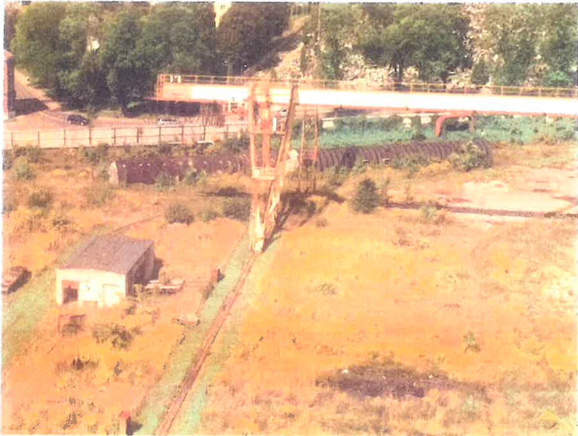
Fot. 9 Suszarnia i budynek olowni drewna - widok z lotu ptaka od strony wschodniej.
