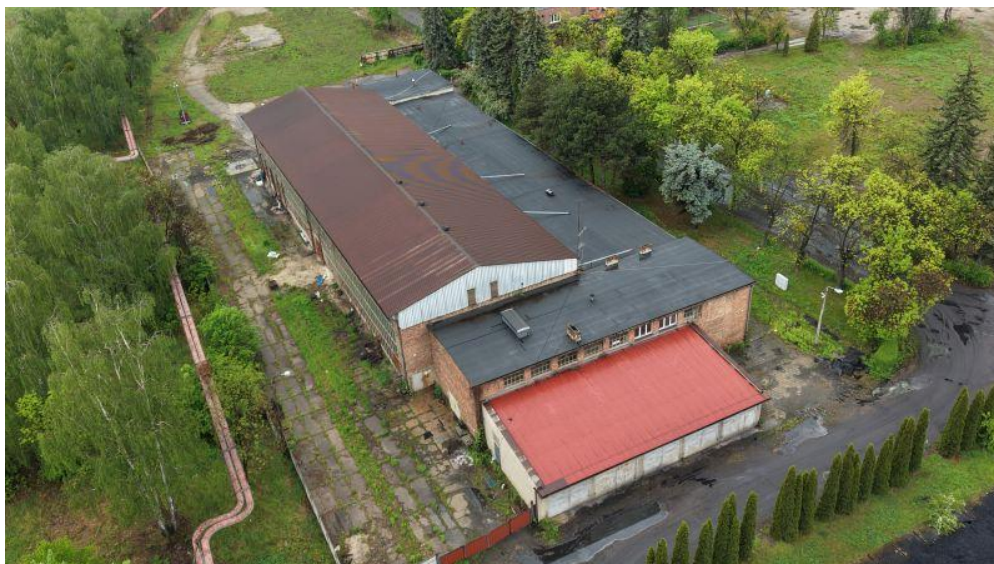
Fot. 2 Budynek warsztatów mechanicznych - widok od strony południowo-wschodniej.
