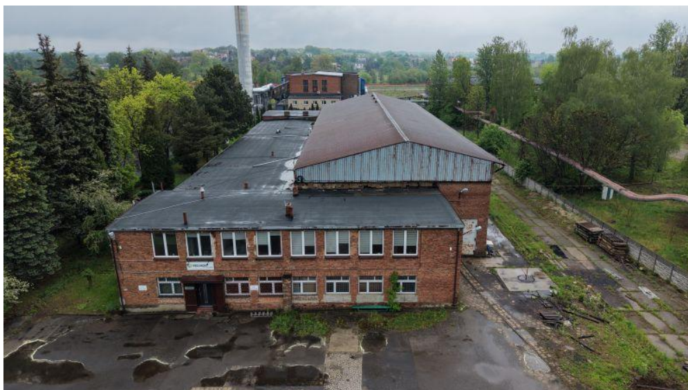
Fot. 5 Budynek warsztatów mechanicznych - widok od strony zachodniej.
