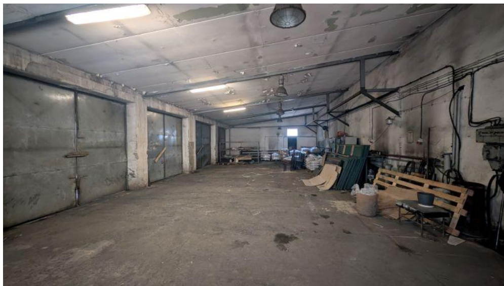
Fot. 10 Budynek warsztatów mechanicznych - widok wnętrza, garaże.
