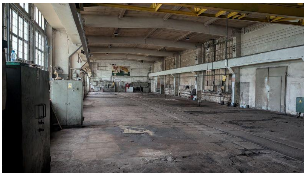
Fot. 9 Budynek warsztatów mechanicznych - widok wnętrza, hala żelbetowa.
