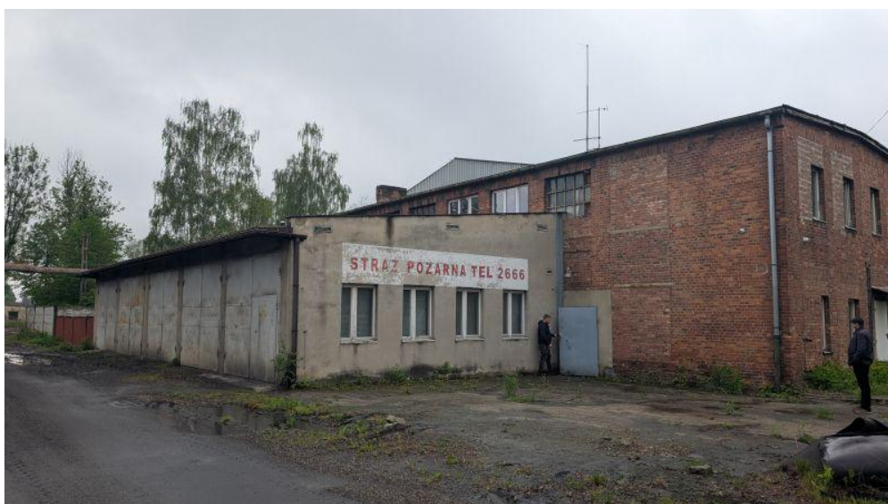
Fot. 6 Budynek warsztatów mechanicznych - widok od strony północno-wschodniej.
