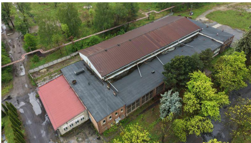
Fot. 3 Budynek warsztatów mechanicznych - widok od północno-wschodniej.
