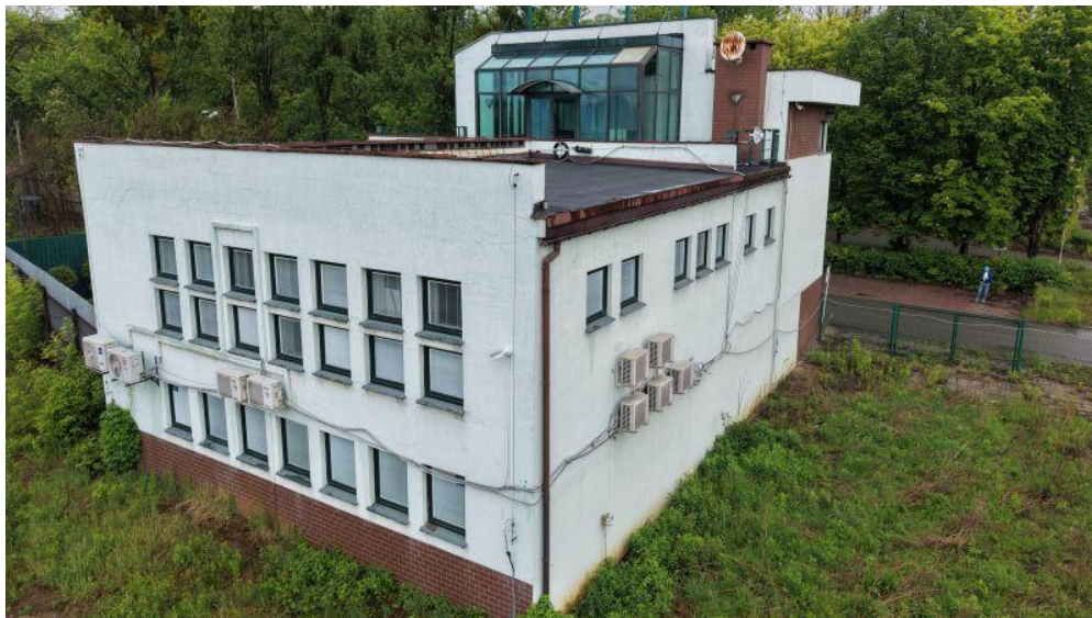
Fot. 1 Budynek administracyjny - widok od strony południowo-wschodniej.
