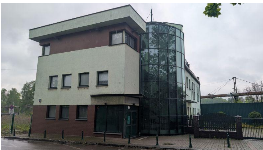
Fot. 3 Budynek administracyjny - widok od strony północno-zachodniej.
